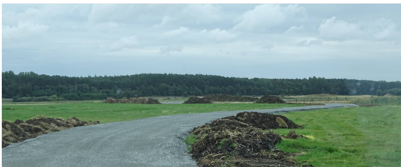
Bau der Zuwegung zum Windpark, Wolfenbüttel, August 2022
